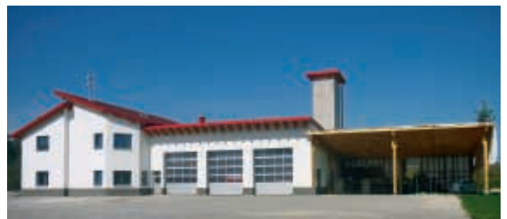
Im August 2012 wurde beim neuen Feuerwehrhaus in Diesendorf ein Unterstellplatz bzw. Carport errichtet.
