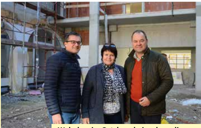
Wohnbau im Ortskern beim ehemaligen Gruberareal nimmt Formen an
