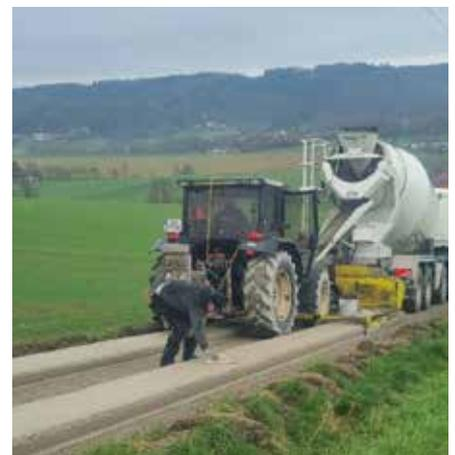
Zusätzlich zu den Arbeiten an den Spurwegen werden in diesem Jahr noch an 2 asphaltierten Teilstücken Reparaturen durchgeführt. Hier wird der Asphalt teilweise erneuert und an Stellen wo eine Reparatur möglich ist Setzungen profiliert und anschließend mit einer DDK (Bitumenemulsion) versehen.
